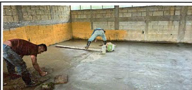
Foto 2: FOTOGRAFIA DE LA COLOCACIÓN DEL PISO.
