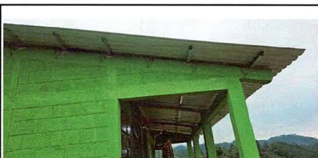
Foto 4: FOTOGRAFIA DE INSTALACIÓN DE BALCONES.
