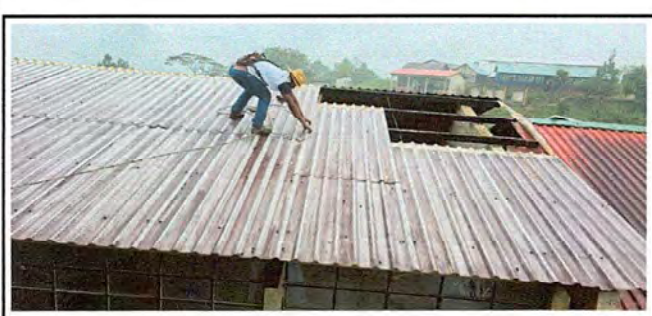
Foto 5: FOTOGRAFIA DE SUSTITUCIÓN DE LAMINAS.
