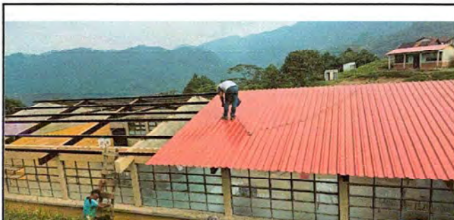
Foto1: FOTOGRAFIA DE LA INSTALACIÓN DE LAMINAS.
