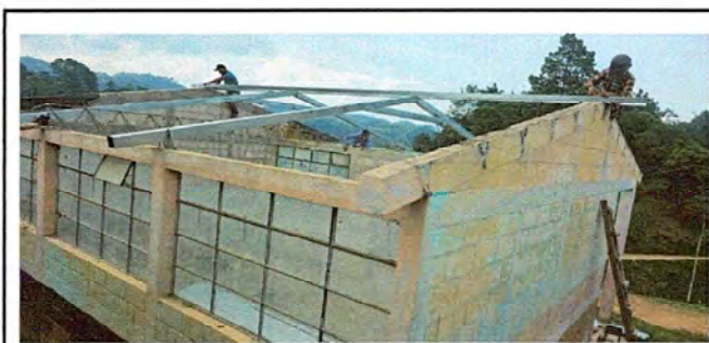
Foto 3: FOTOGRAFIA DE INSTALACIÓN DE ESTRUCTURA METALICA.
